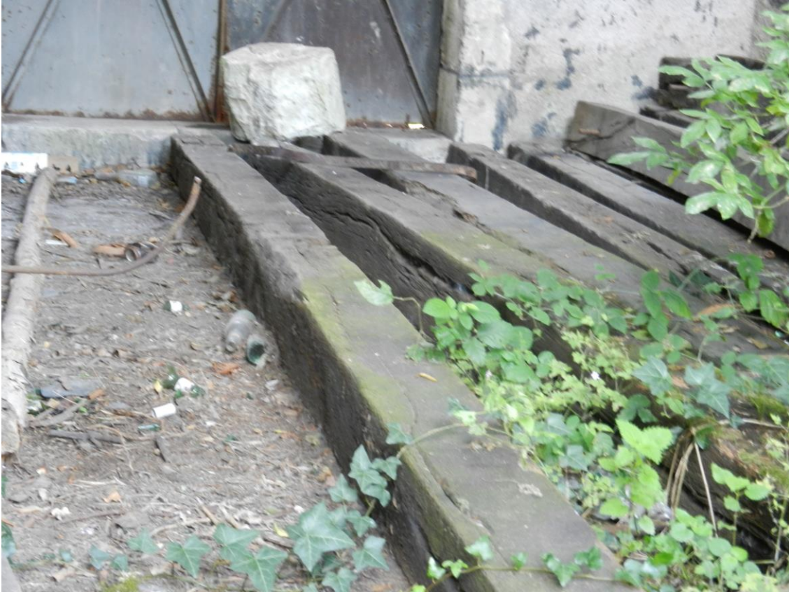
Il ne reste de cette époque qu'une douzaine de poutrelles.
